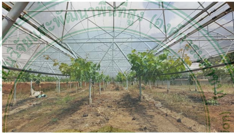
ภาพที่ 2 โรงเรือนและค้ำตัววายสูง 2 เมตร แบบหลังคาปิดขนาด 3 x 20 เมตร
