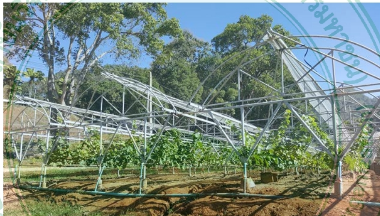
ภาพที่ 5 โรงเรือนและค้ำตั้งตัววายต่ำ 1.5 เมตร แบบหลังคาปิด-เปิด ขนาด 3 x 20 เมตร
